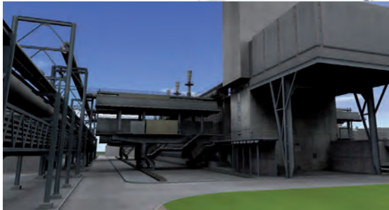
Die Infrastruktur – hier die Kokerei – wird per 3D-Mittelstrecken-scanner erfasst und die Punktwolken werden anschließend mit Auto-desk LandXplorer Studio Professional aufbereitet und visualisiert.
