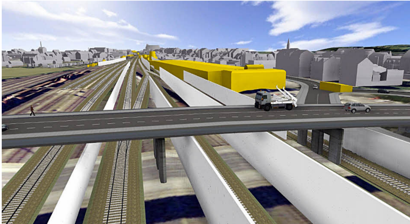
Der Blick über die Pfisterbrücke nach Süden zeigt die teilende Wirkung von vier Mauern, von denen die beiden mittleren sechs Meter hoch sind. Bei den gelb dargestellten Gebäuden rechts oben handelt es sich um bahneigene Hallen an der Strickerstraße und das Betriebsgebäude von Wolf und Reiser, die dem viergleisigen Trassenbau im Weg stehen.
